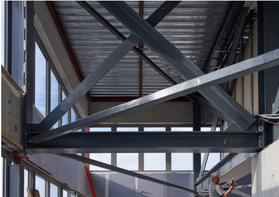
TREILLIS PORTEUR PRINCIPAL
